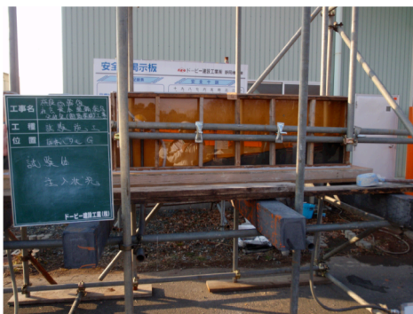
注入実験状況写真↑
